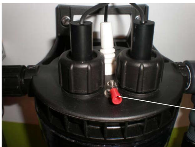
Anschluss des Potentialausgleichs an der „NPED4“ – Durchflussarmatur mit einem 2,5 mm<sup>2</sup> PE-Kabel (Gelb/Grün)
